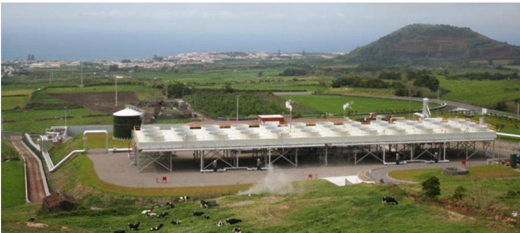
Central Geotérmica de Pico Vermelho 10 MW (2007)
